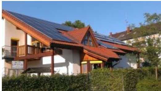
Fotovoltaik auf der Kita Schelmböhl
