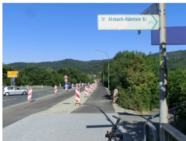
Radweg Richtung Alsbach im Bau
